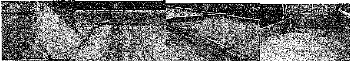
SE HACE LIMPIEZA DE RUTINA DE CANALETAS
