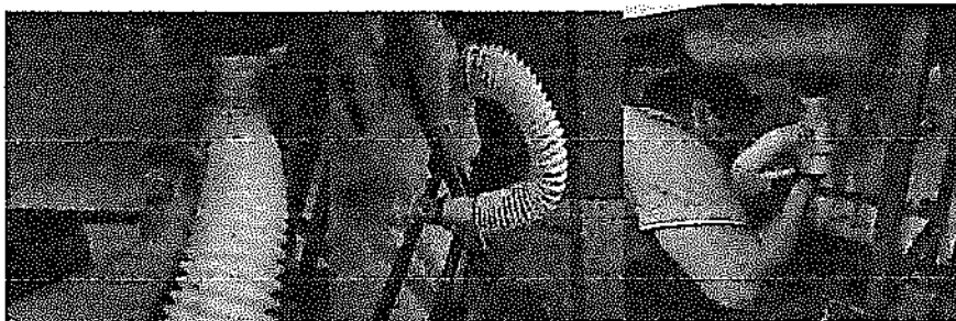
Se destapa tubería tapada en el área del fregadero de la cocineta de producción
